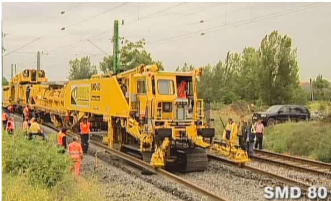
Рисунок 1.10 – Процесс укладки бесстыкового пути на железных дорогах Казахстана
