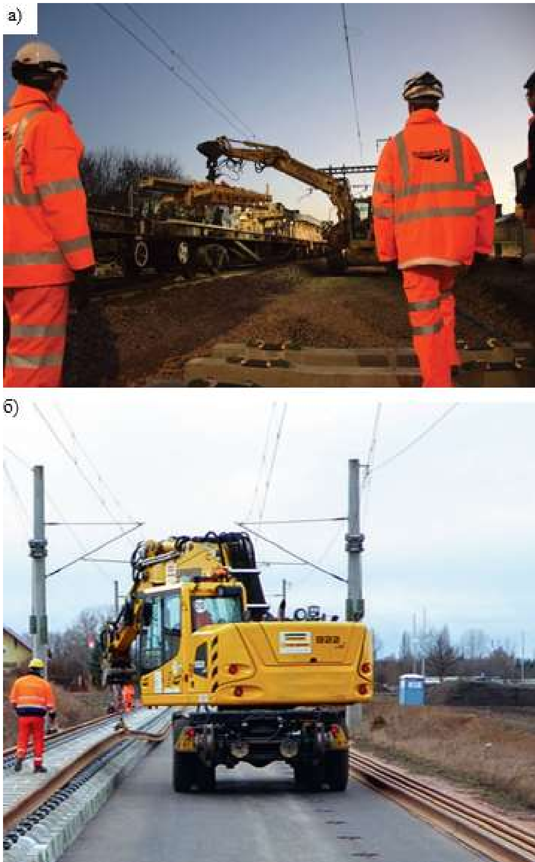
а) процесс раскладки шпал; б) процесс укладки рельсовых плетей
