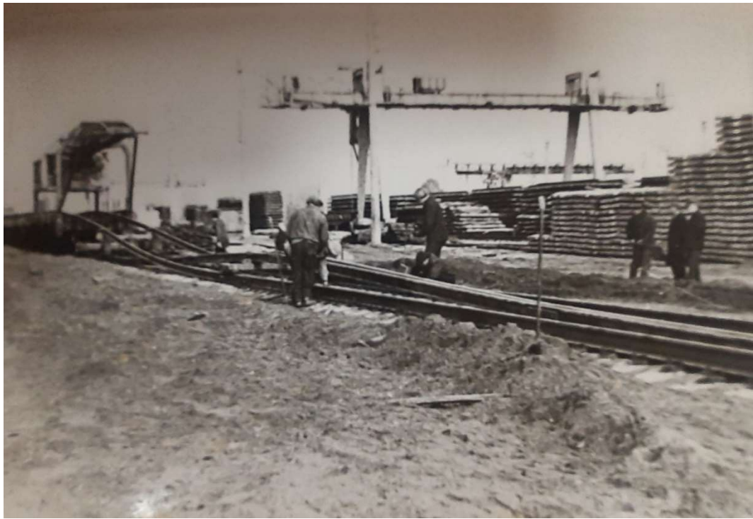
Рисунок 1.9 – Испытания плетеукладчика на путях производственной базы ОПМС-1
