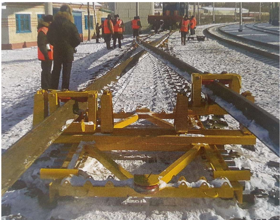
Рисунок 1.13 – Процесс перекладки рельсовых плетей
