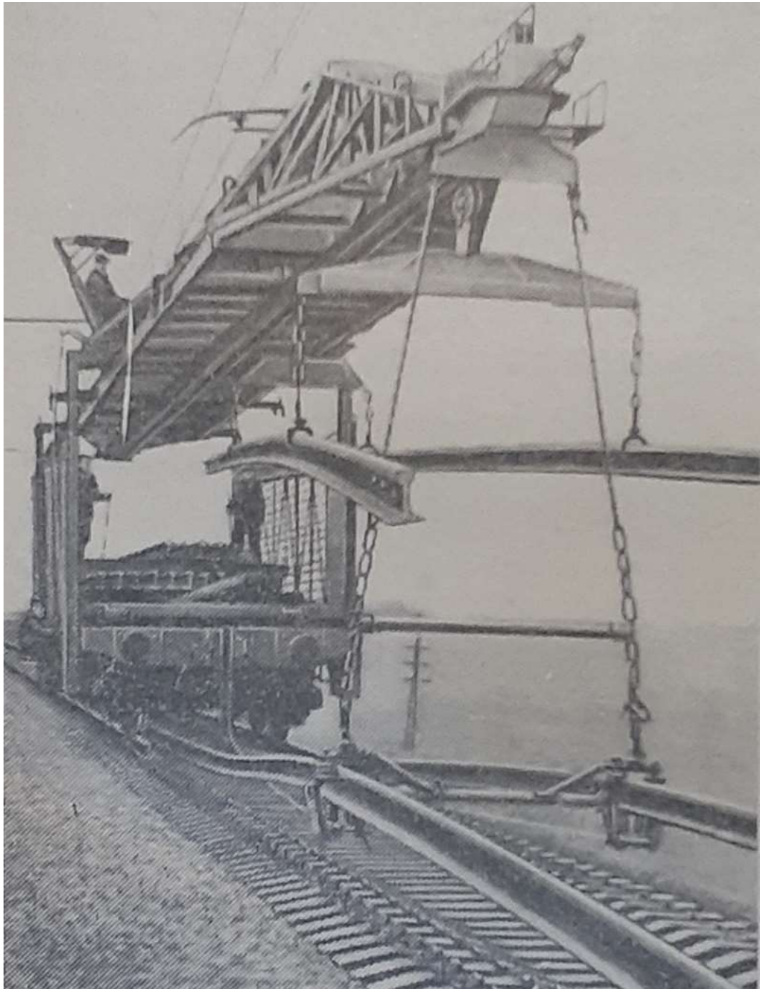
Рисунок 1.8 – Укладка бесстыкового пути путеукладчиком с помощью приспособления инж. К.Г. Арутюняна
