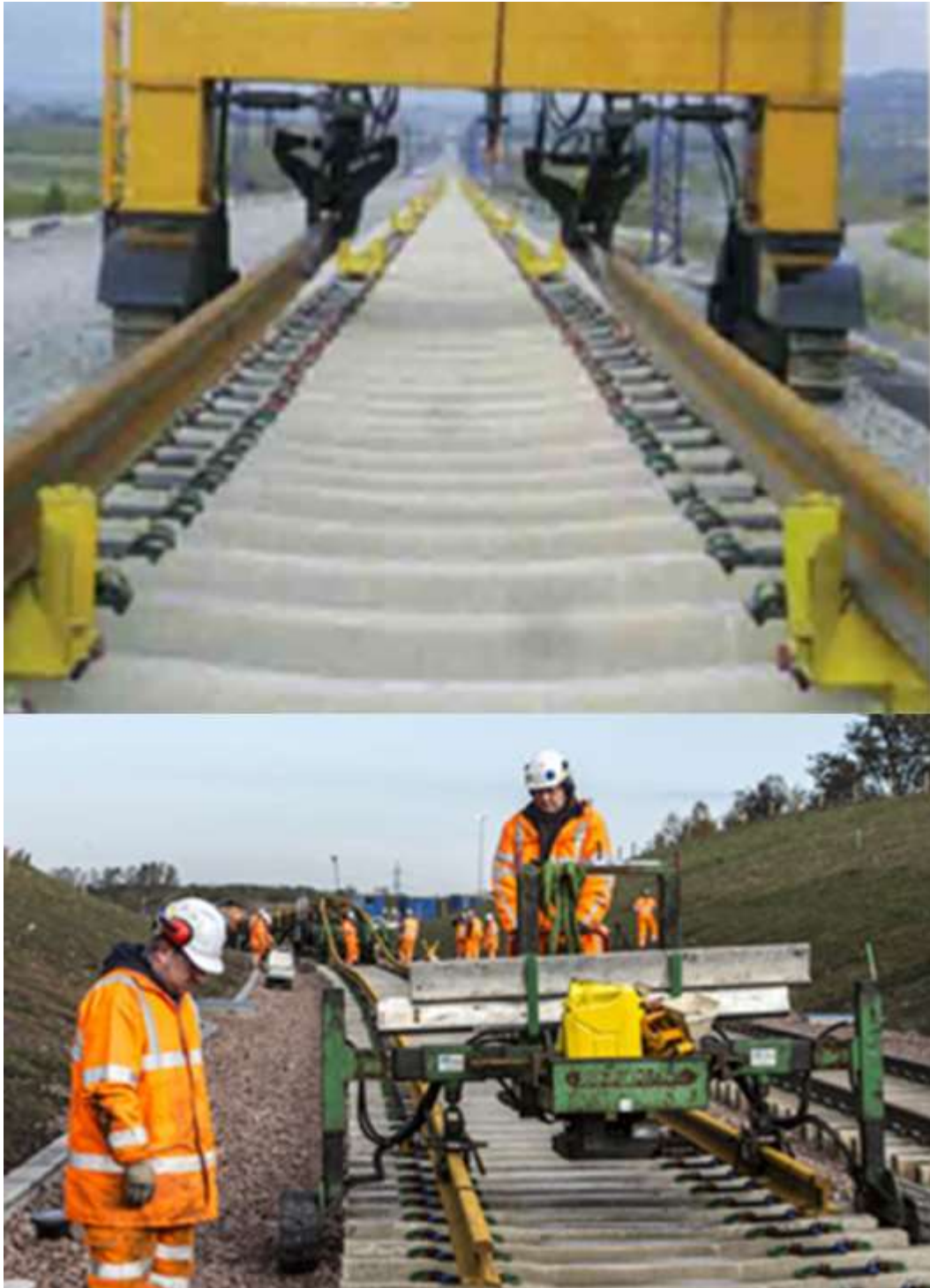
Рисунок 1.18 – Укладка плетей с применением машин на гусеничном ходу
