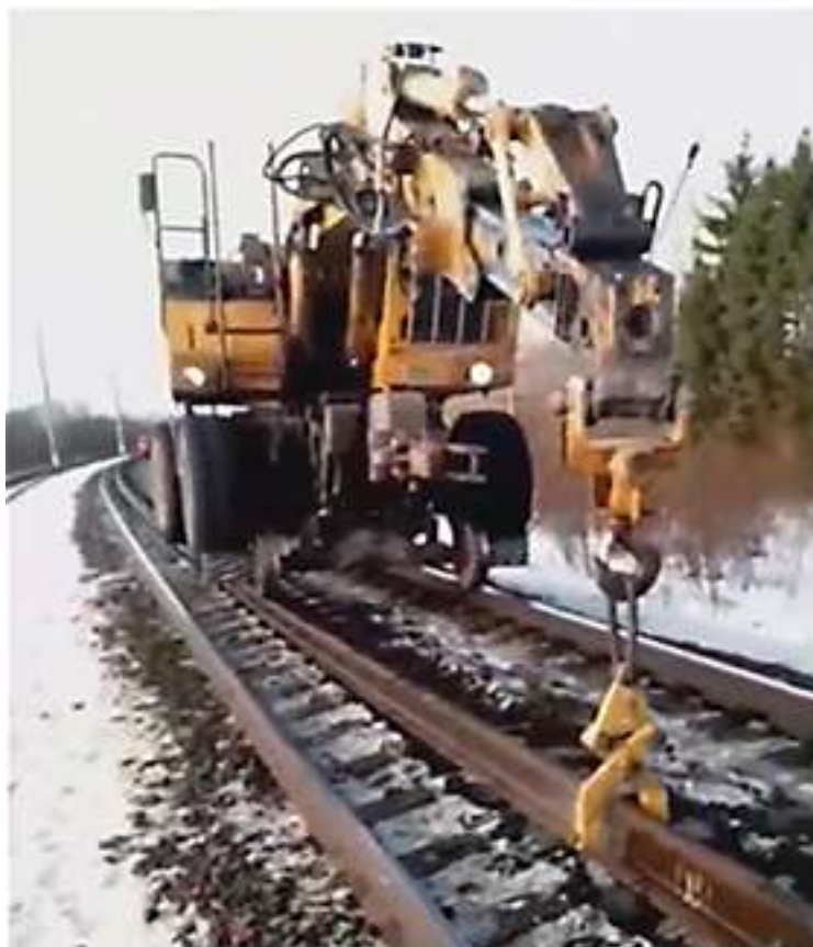
Рисунок 1.15 – Процесс смены рельсовых плетей на Грязовецкой дистанции пути
