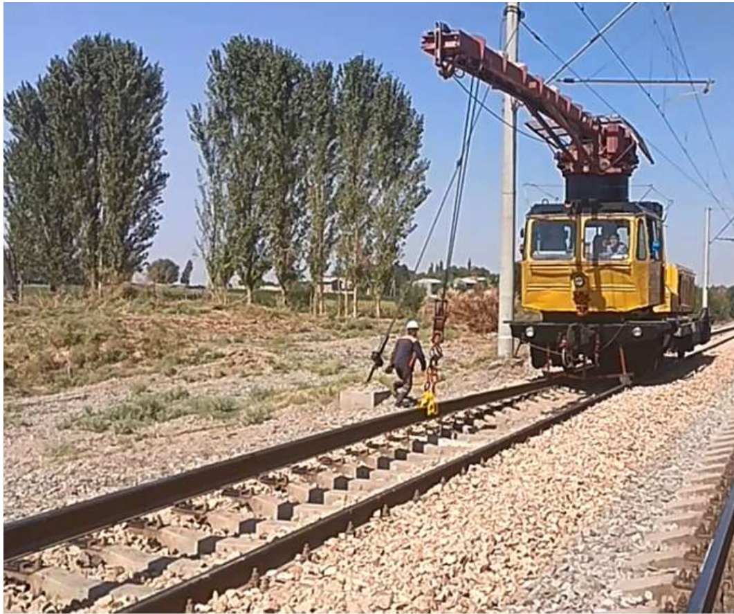
Рисунок 4.2 – Процесс надвигки рельсовой плиты на перегоне Назарбек-Далагузар
