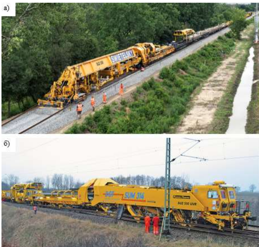
а – укладка нового пути; б – процесс замены
