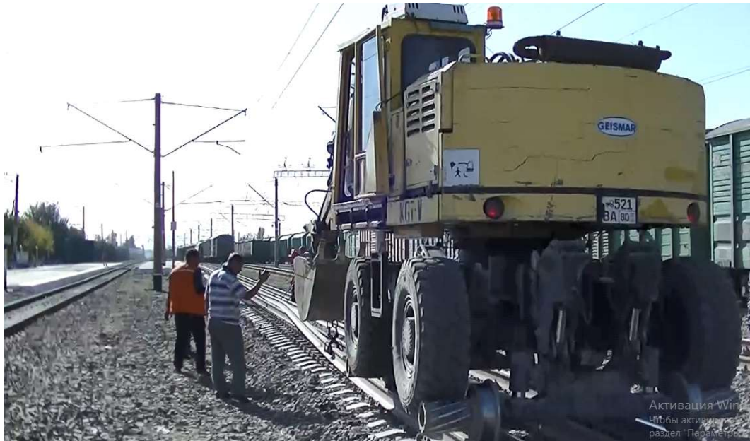
Рисунок 4.4 – Процесс надвигки рельсовой плети на станции Рахимова
