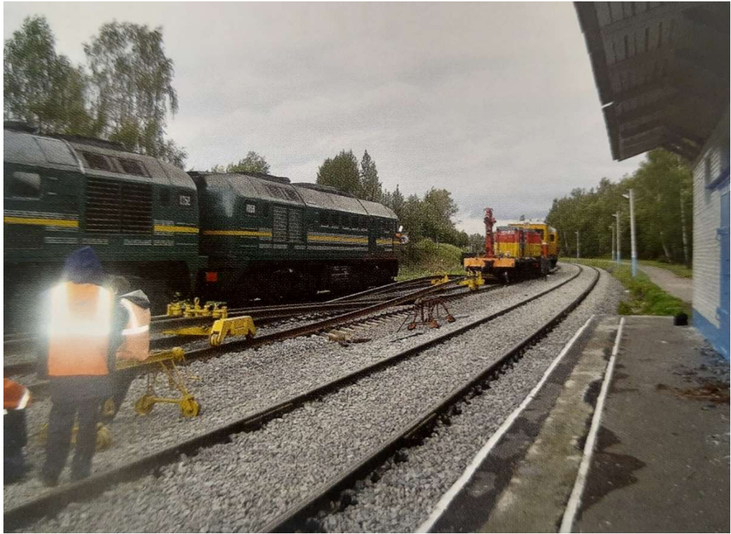
Рисунок 1.12 – Процесс замены рельсовых плетей с применением тележек конструкции ПТКБ
